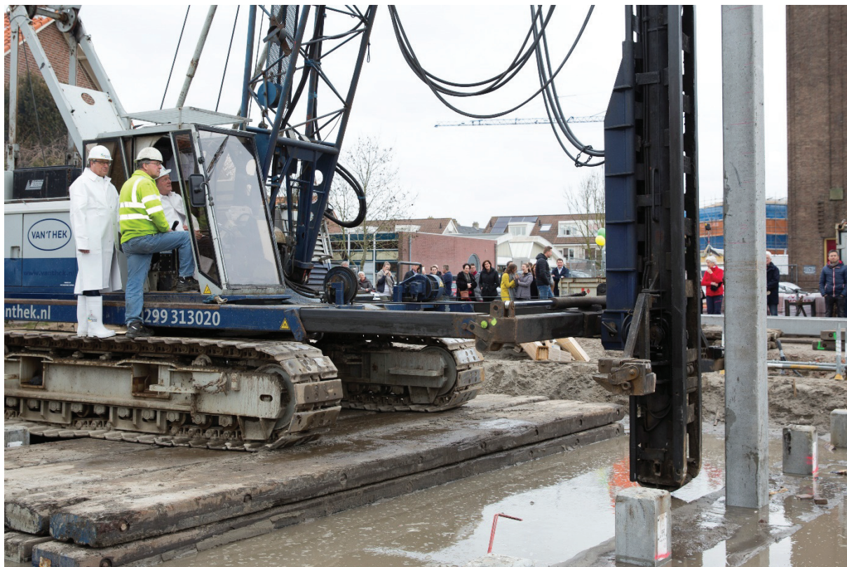
Eerste paal nieuwbouwproject Lievenvrouwenhof Halfweg
