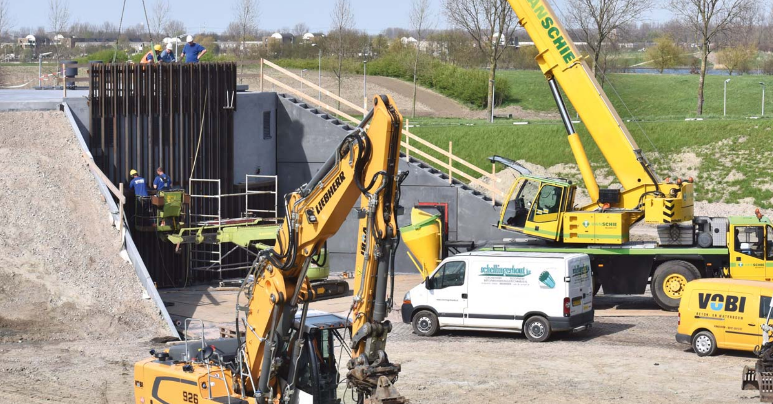
PARK21 bouw gemaal
