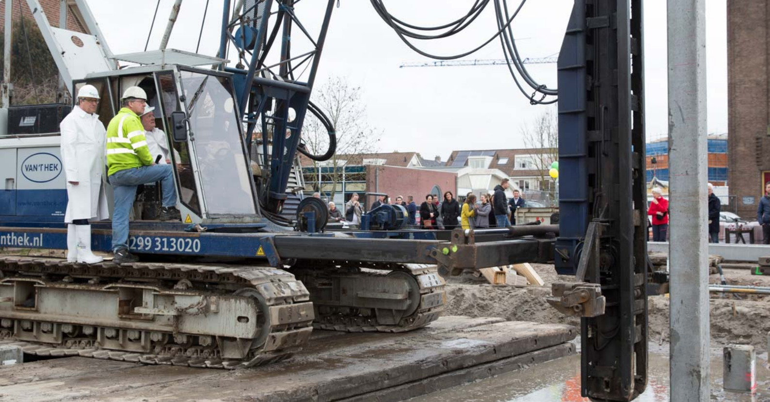
Eerste paal nieuwbouwproject Lievenvrouwenhof Halfweg
