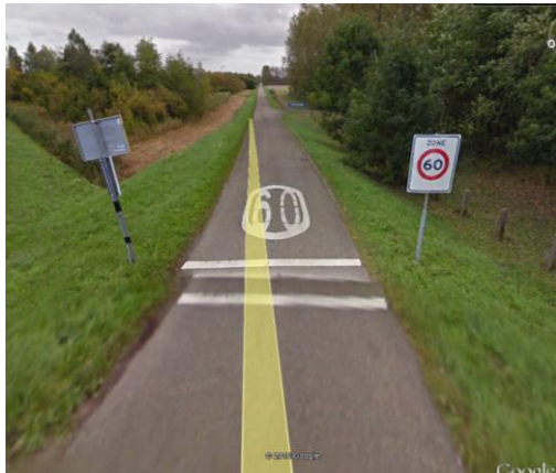
Te verwijderen 60km marking en verkeersborden
