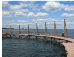
OF A2/B2/C2. Brug in water, loopniveau is onder boezempeil (NB: Dit voorbeeld is een fiets-/loopbrug. Uitvoering als loopbrug is halve breedte)
