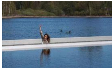
OF A2/B2/C2. Brug in water, loopniveau is onder boezempeil (NB: Dit voorbeeld is een fiets-/loopbrug. Uitvoering als loopbrug is halve breedte)
