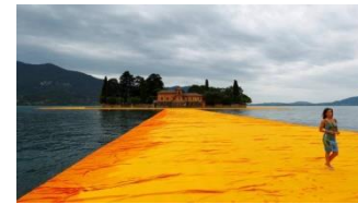
C1. Vlonders van kunststof drijvende blokken verankerd aan de bodem
