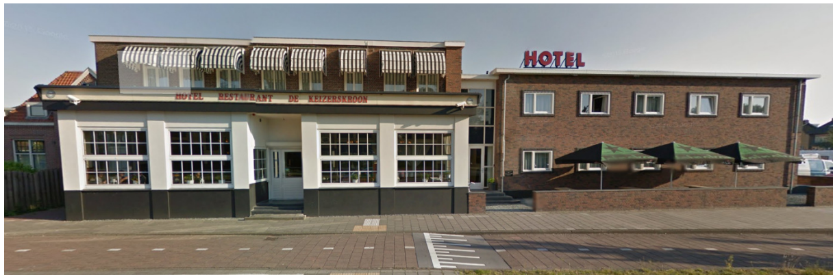
Beeld van De Keizerskroon. Links het bestaande bouwdeel. Rechts de nieuwbouw.
