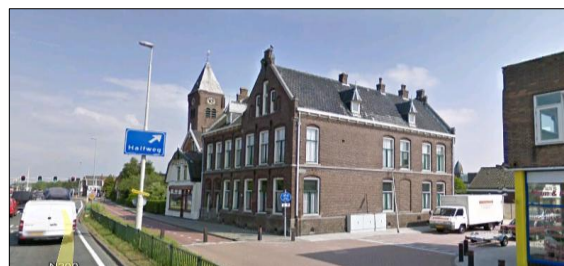
Het ( voormalige ) Dependancegebouw
