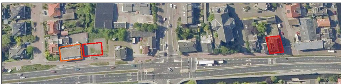
Het Hoofdgebouw, de Nieuwbouw en het ( voormalige ) Dependancegebouw
