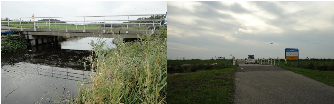
Betonnen brug tussen Spaarndammerdijk en Houtrakkerweg
