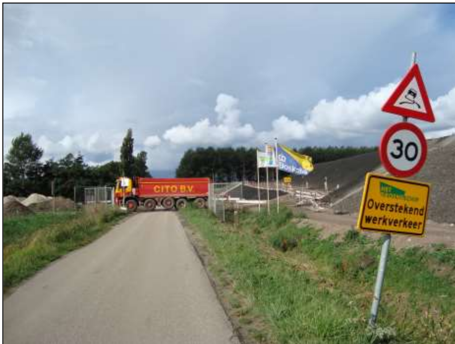
Afbeelding: aanleg Groene Schip ter hoogte van de Noorderweg (september 2013)
