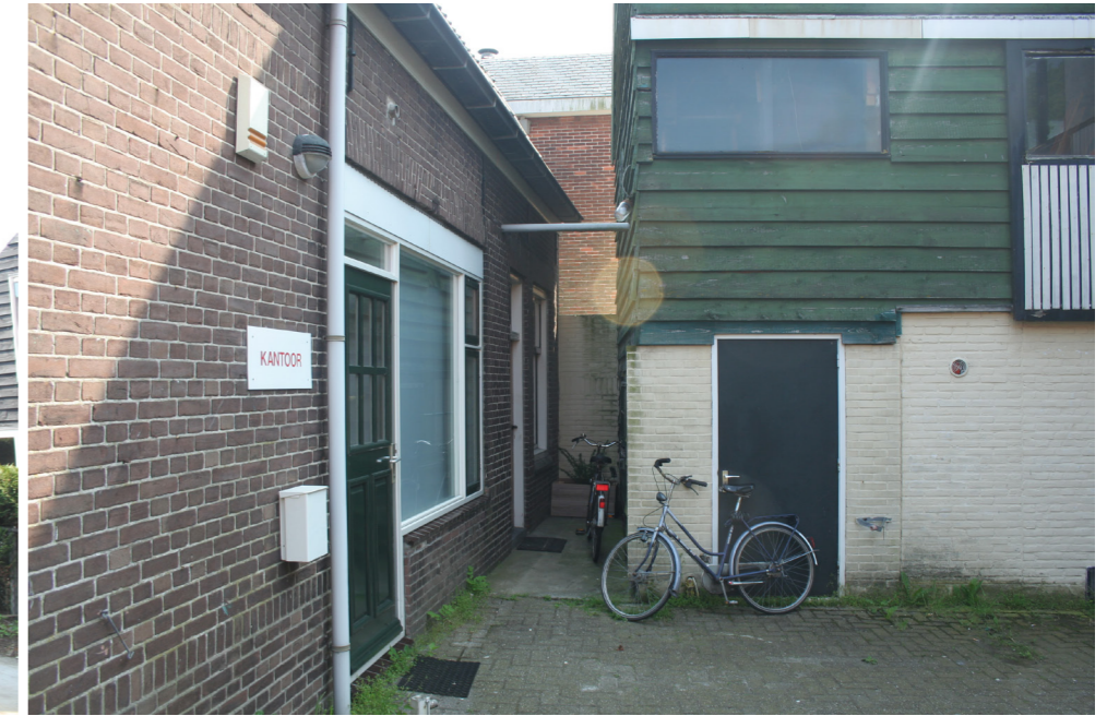
Huidige aansluiting woning-werkplaats
