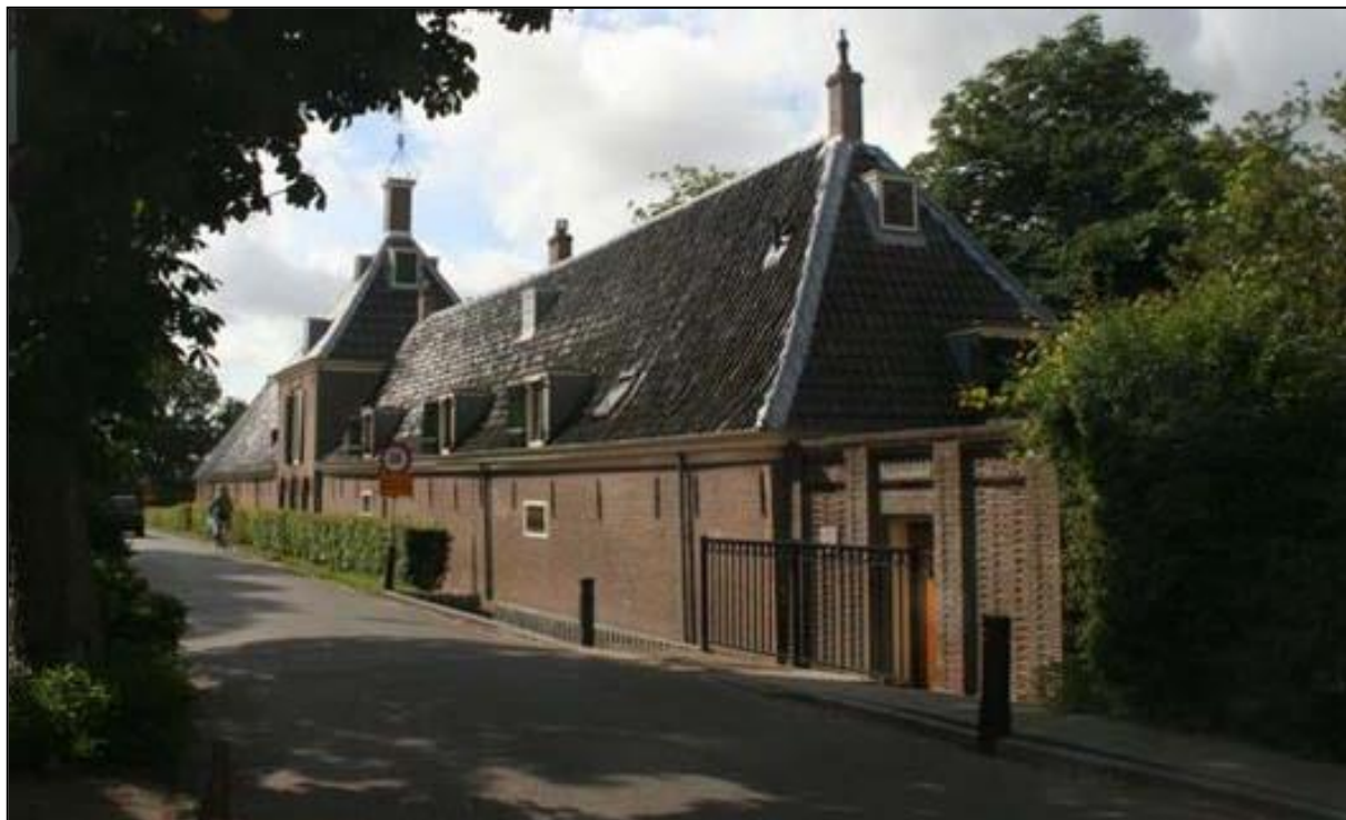
Afbeelding: Gemeenlandshuis, gezien vanaf de Spaarndammerdijk
