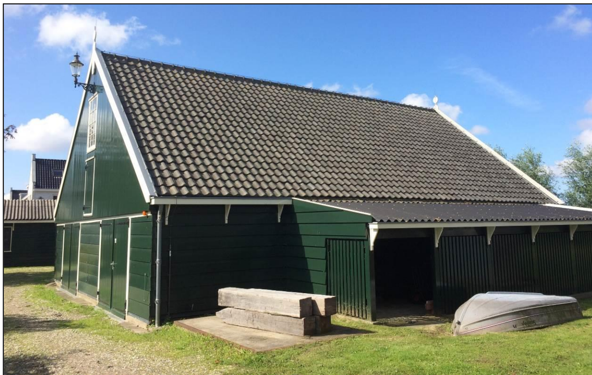
Afbeelding: het gebouw van de houtopslag
