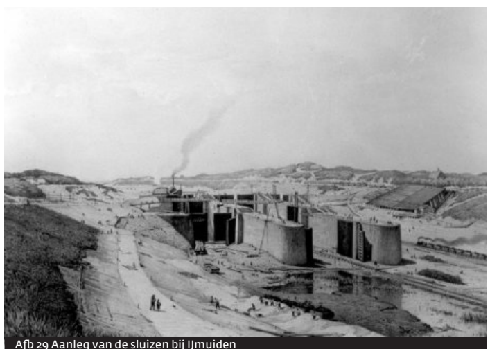
Afb 29 Aanleg van de sluisen bij IJmuiden
