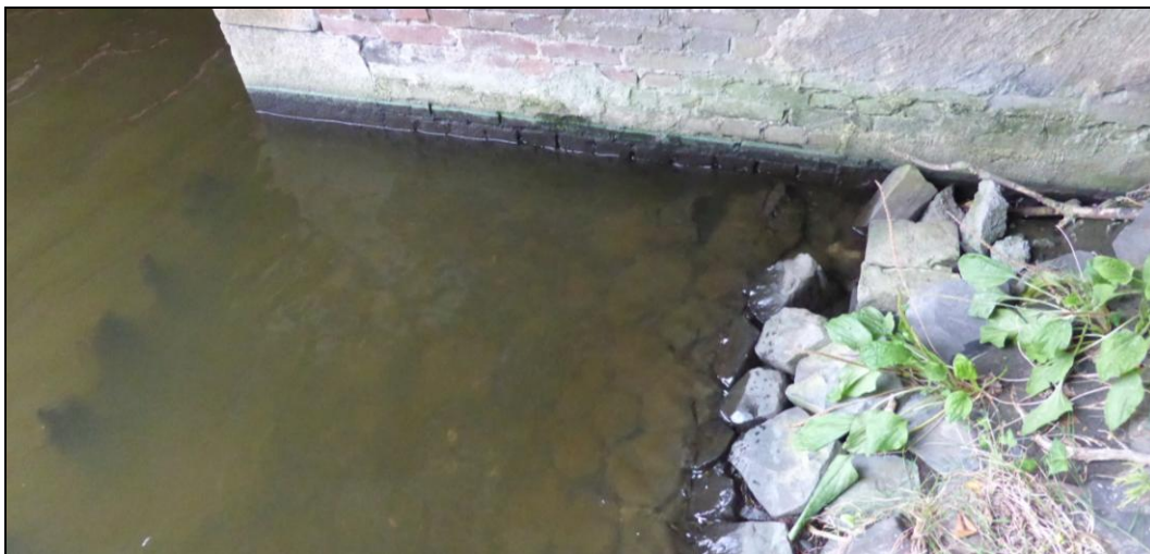
Afbeelding 16. Steenstort rond brugpijlers.
