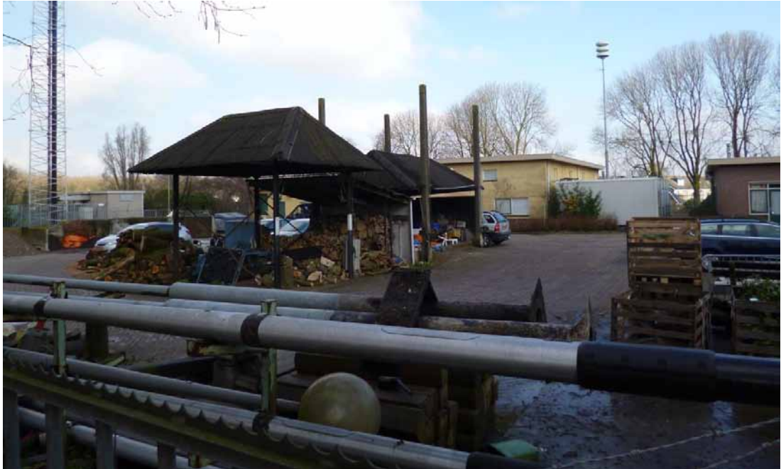
Figuur 2.2 aanzicht gemeentewerf met beide gebouwen vanaf het zuiden
