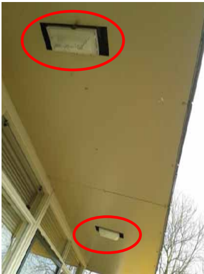
Figuur 4.3 overkapping oostelijk gebouw
