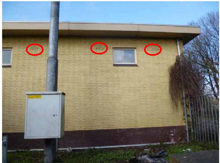
Figuur 4.4 toegang tot muren westelijk gebouw
