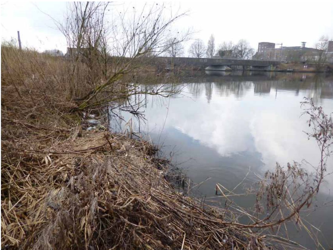
Figuur 3.1 aanzicht oever van Zijkanaal F richting het zuiden met de spoorbrug
