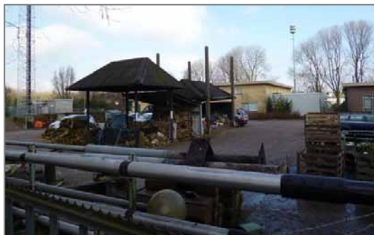
Figuur 2.2 aanzicht gemeentewerf met beide gebouwen vanaf het zuiden
