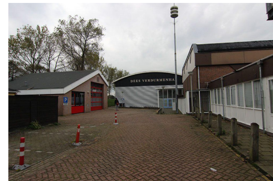
bestaande situatie - sporthal + brandweerkazerne
