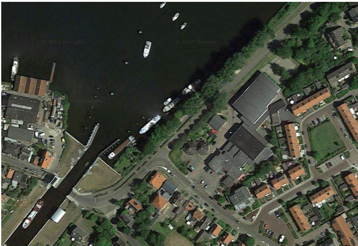
luchtfoto: bestaande situatie dorpshart
