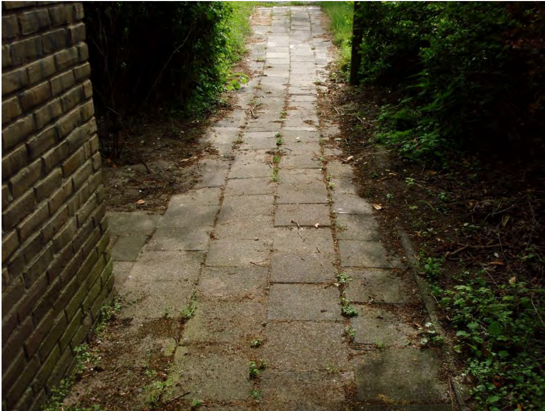
Foto 19 – De toegangsdeuren van de bovenbouw zijn niet bereikbaar voor een onderhoudswagen/tegelpad ligt ongelijk
