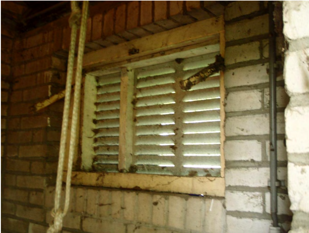
Foto 13 – Ventilatioerooster bovenbouw (droge kelderzijde)
