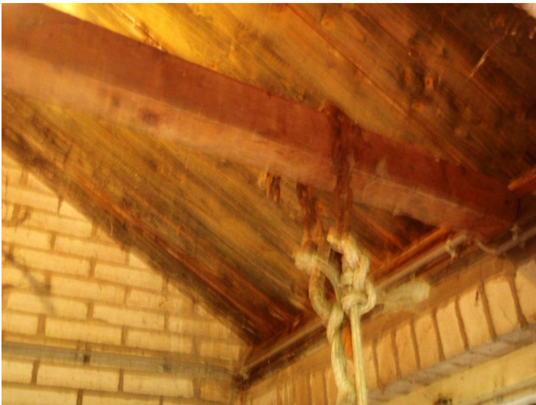
Foto 14 – Bevestiging takel aan balk dakconstructie
