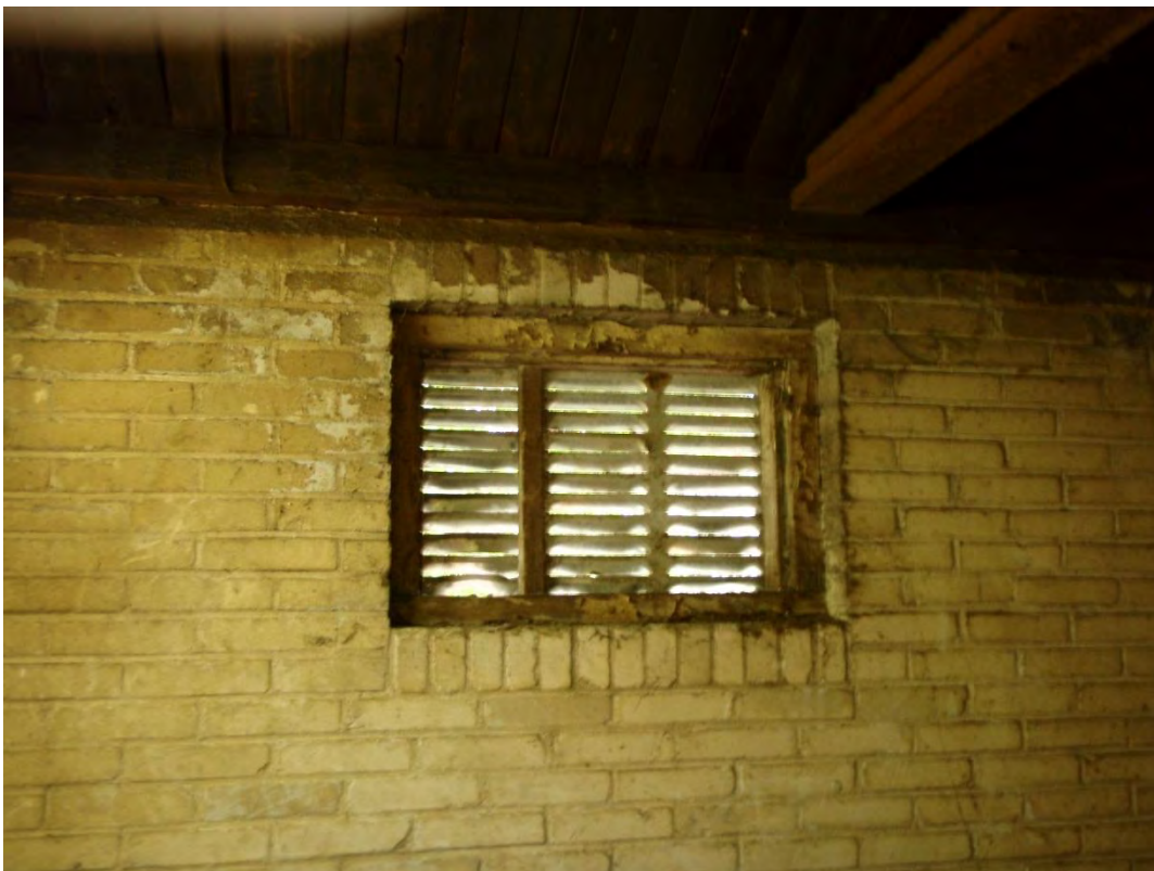
Foto 10 – ventilatierooster natte kelder
