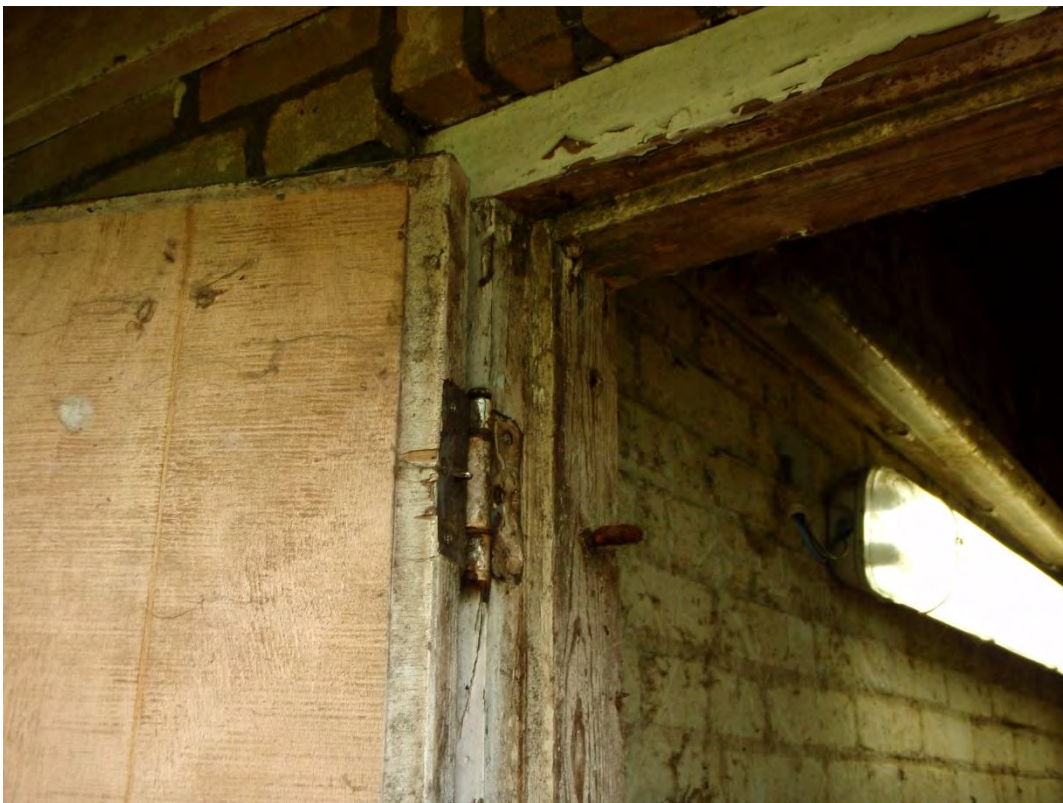
Foto 6 – Deur natte kelder
