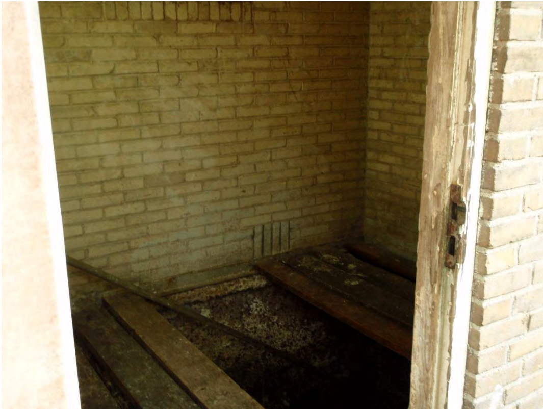
Foto 7 – Balkenvloerdelen natte kelder
