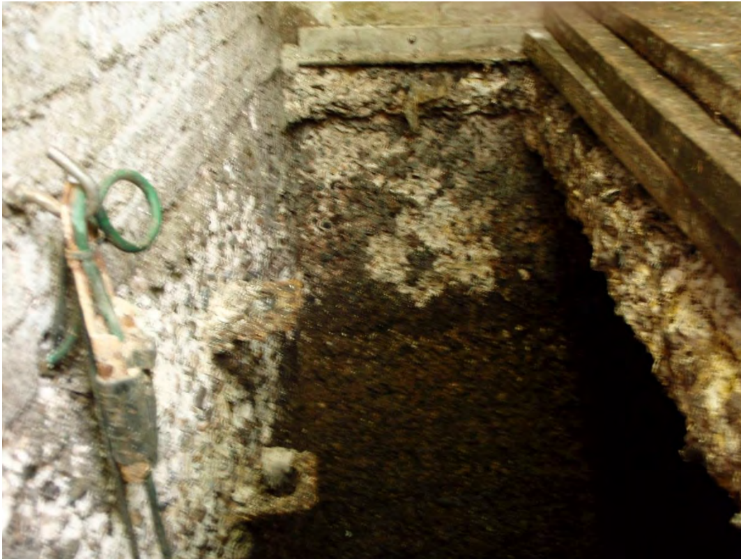
Foto 9 – Betonnen kelderwand en betonnen dwarsbalk natte kelder
