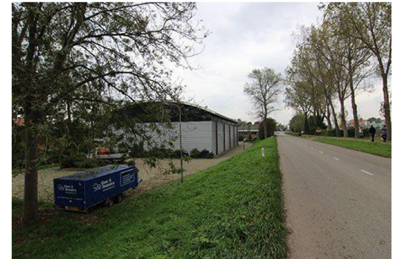
bestaande situatie - Zijkanaal C weg
