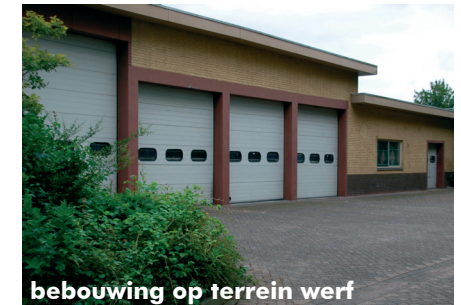
bebouwing op terrein werf
