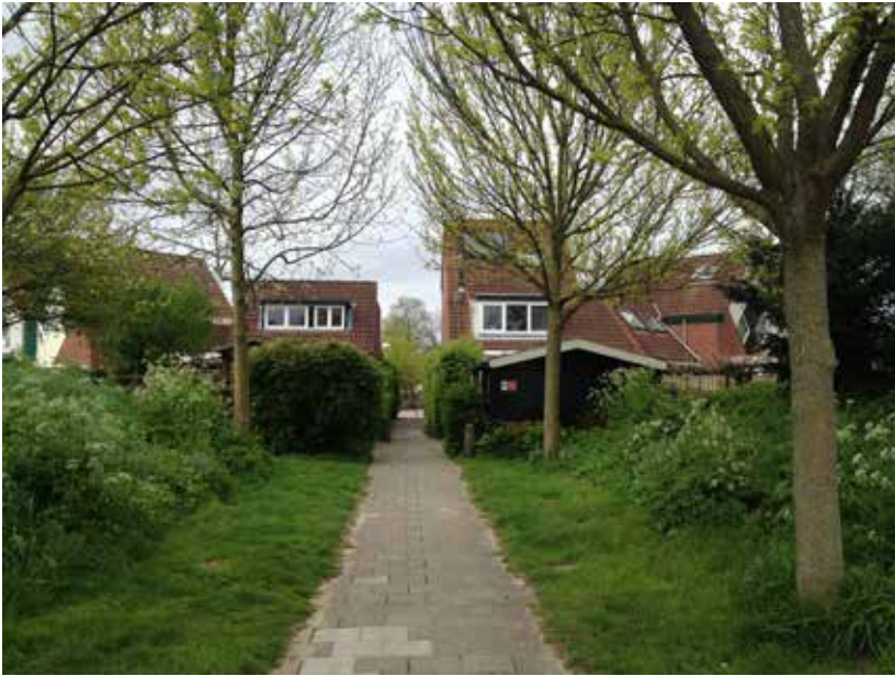
voetpad door het groen en de geschakelde woningen
