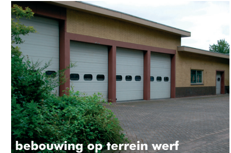
bebouwing op terrein werf
