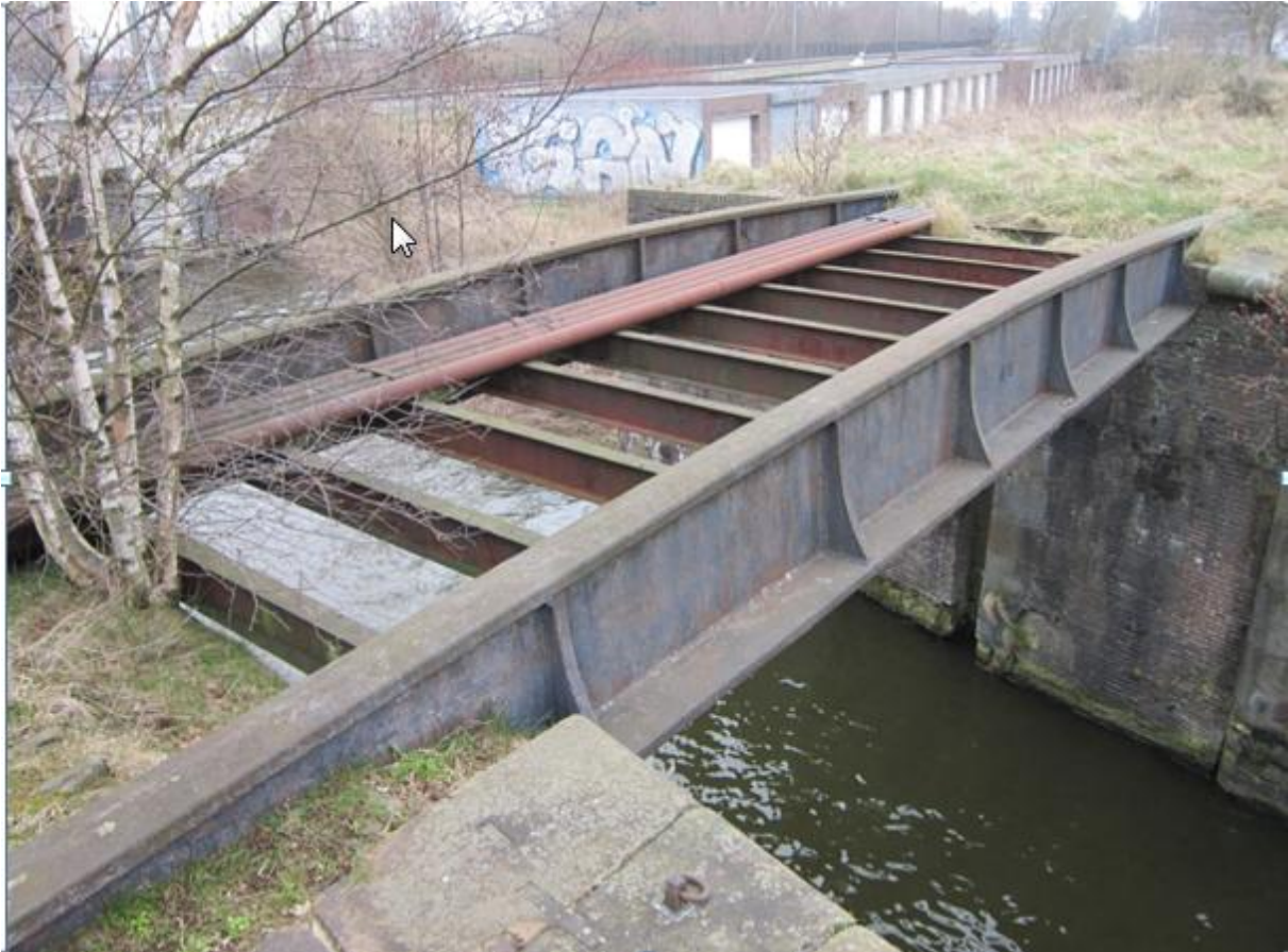
Afbeelding 40: De spoorbrug uit 1868, huidige situatie.
