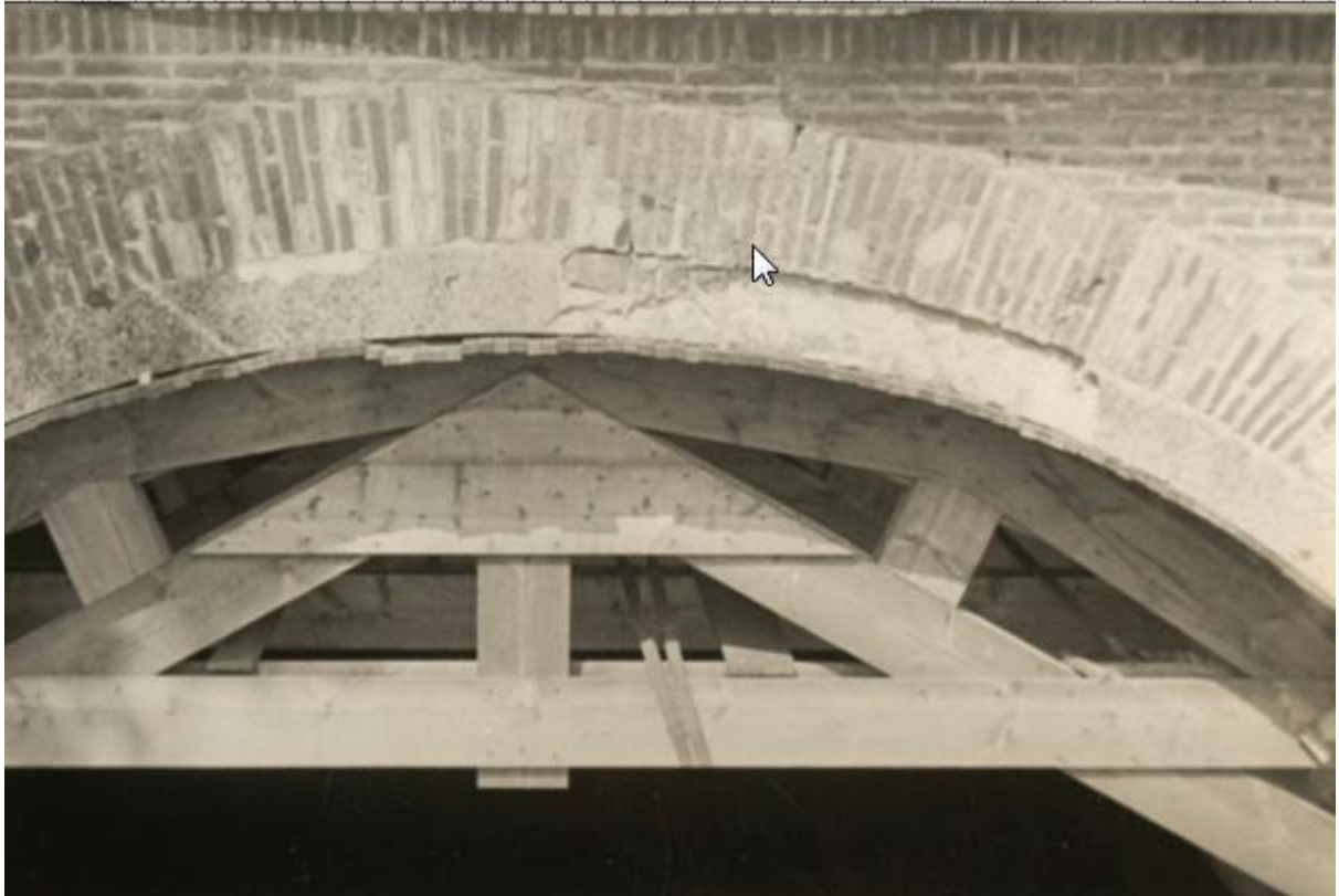
Afbeelding 37: Gebreken aan de Middensluis in 1935.
