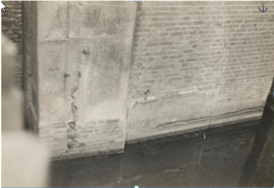
Afbeelding 38: Gebreken aan de Middensluis in 1935.
