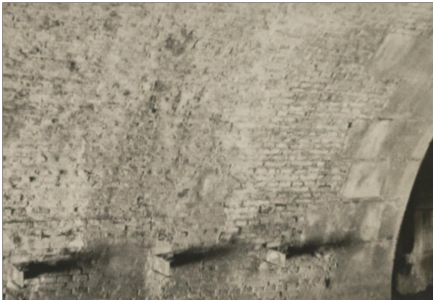
Afbeelding 38: Gebreken aan de Middensluis in 1935.
