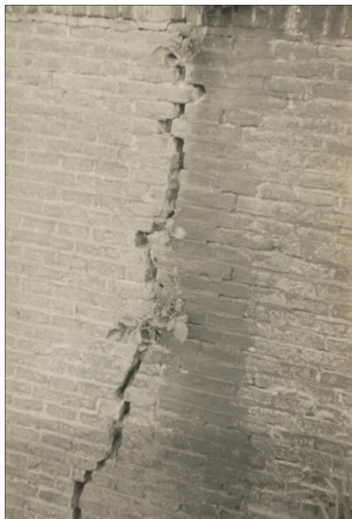
Afbeelding 35: Gebreken aan de Middensluis in 1935.
