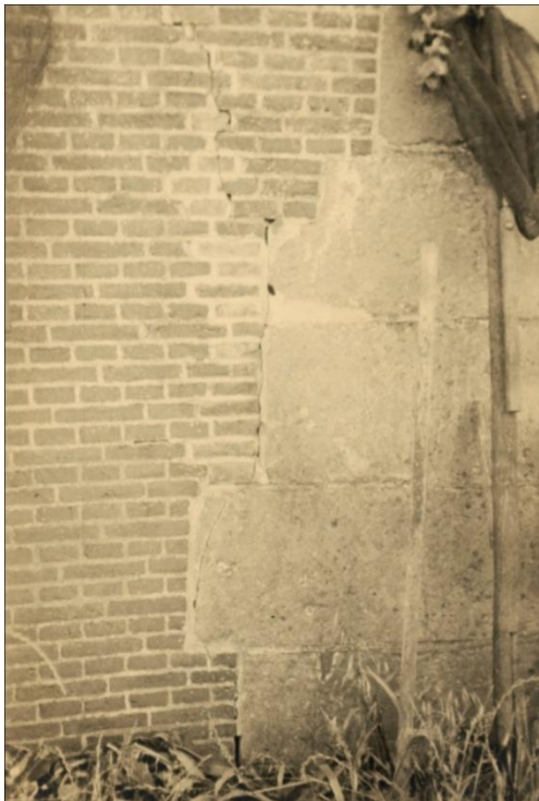
Afbeelding 34: Gebreken aan de Middensluis in 1935.
