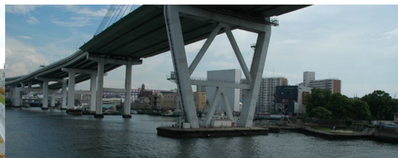
infra als onderdeel stadsbeeld / snel personenvervoer over het water
