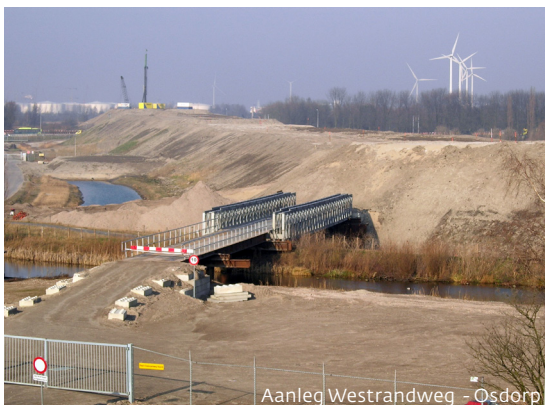
Aanleg Westrandweg - Osdorp
